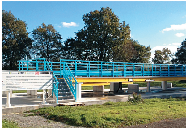
Le démonstrateur DECID2 installé à l'Ifsttar de Nantes.
